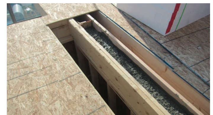
▲ 세대와 세대 사이에 세운 콘크리트 차움벽
